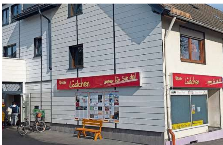
Der neue Seiteneingang und das Pflaster sind optisch an den Saal Hütten angepasst.
